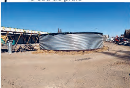
Cuve de récupération d'eau de pluie
