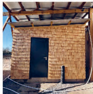
Silo à bois déchiqueté alimentant la chaudière biomasse
